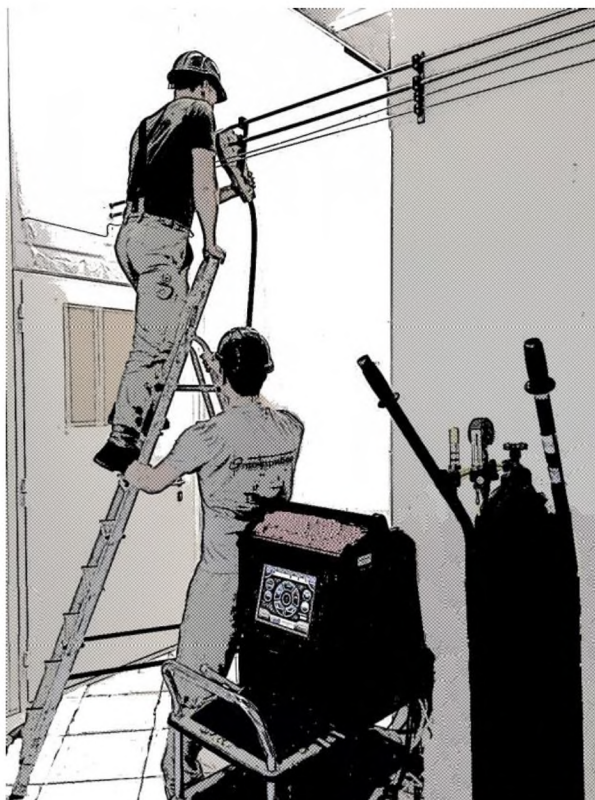
Рис.5 Монтаж трубопровода на стремянке
